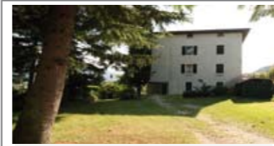
H005: TERLAGO: PORZIONE TERRA-CIELO, oltre 300 mq su tre livelli, da sistemare, parco verde esterno con vialetto di accesso; ideale per ricavarne soluzione bi/tri-familiare, Cl. En. F € 280.000
